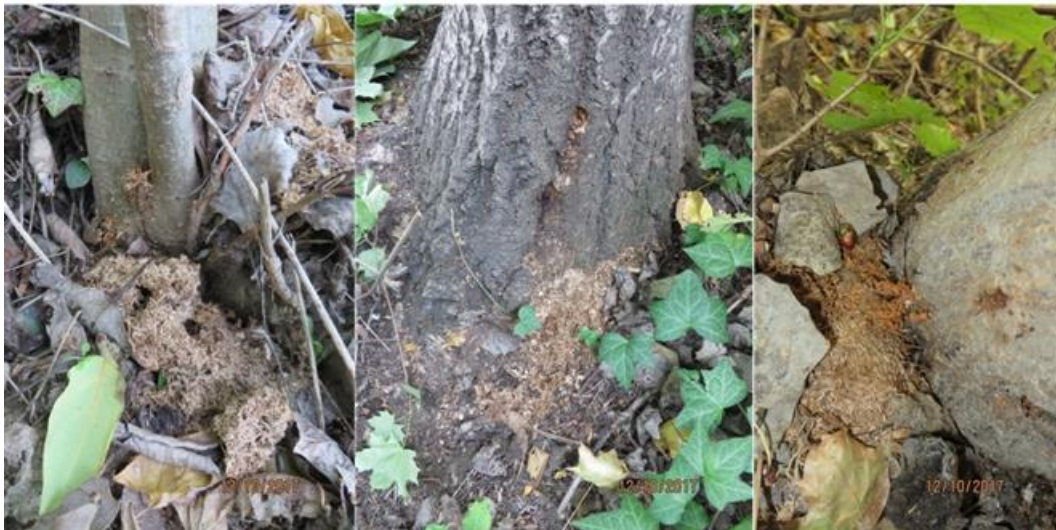
Massiver Befall mit sehr starkem Bohrspäneauswurf im Stammfußbereich junger (links) und mittelalter (Mitte u rechts) Pappeln
